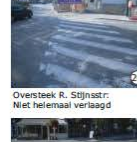
Oversteek R. Stijnstr. Niet helemaal verlaagd
