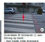
Oversteek M. Grünerstr. // aan Stnw op Gent: - Aan beide zijde drempels - Lantaarn in midden zebra
