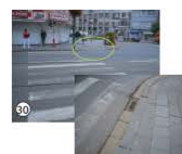
Oversteek Stnw op Gent: - Waterkolk in looproute - Stoeprandverlagingen naast het zebrapad
